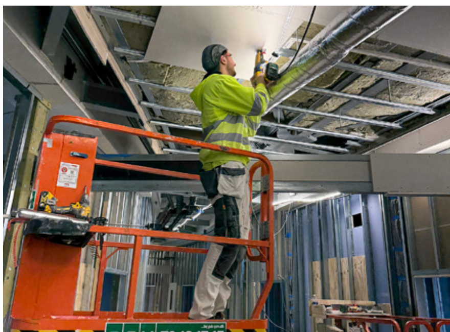
Ertan i sving med sætte gips op.
